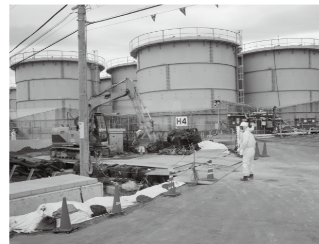
汚染水貯留タンク
