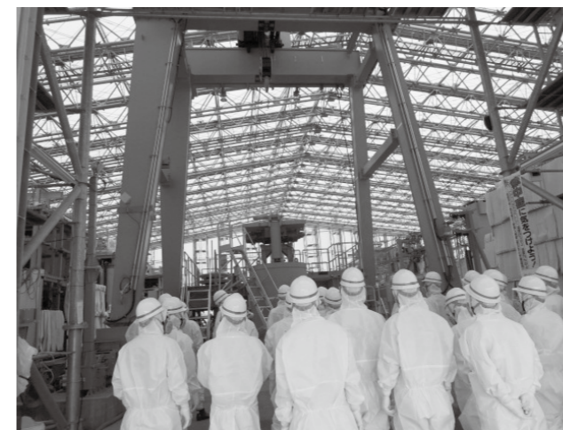
多核種除去設備(ALPS)
